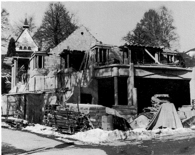
Die Bauarbeiten schreiten zügig voran.
